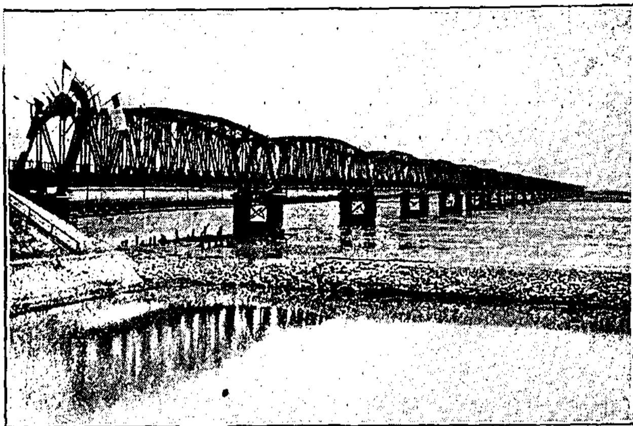
Общій видъ Аму-дарьинскаго желѣзно-дорожнаго моста. Длина моста—750 саж.
