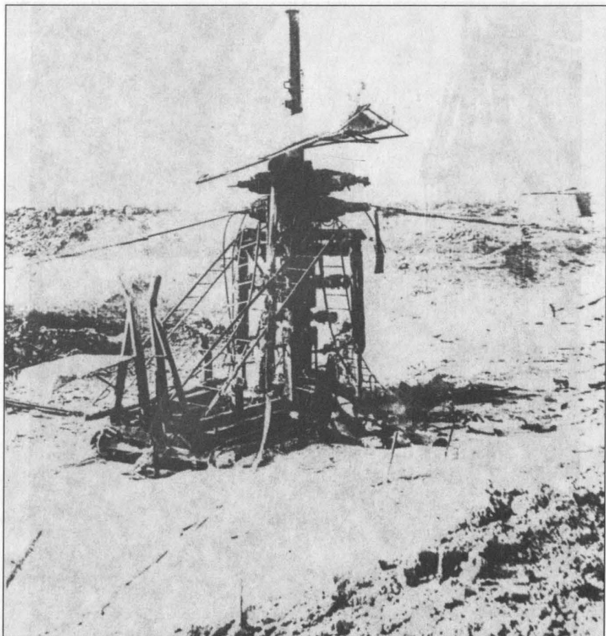
Фото 4.18. Скважина по состоянию на 02.01.1986 г.
