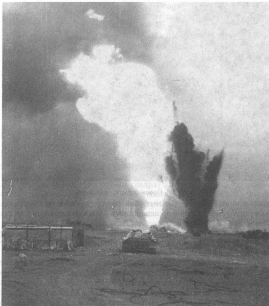
Фото 3.7. Взрыв накладного заряда КЗ-4 в зоне устья скважины
