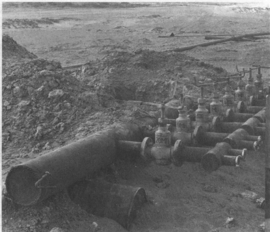
Фото 3.2. Система подачи воды на устье скважины
