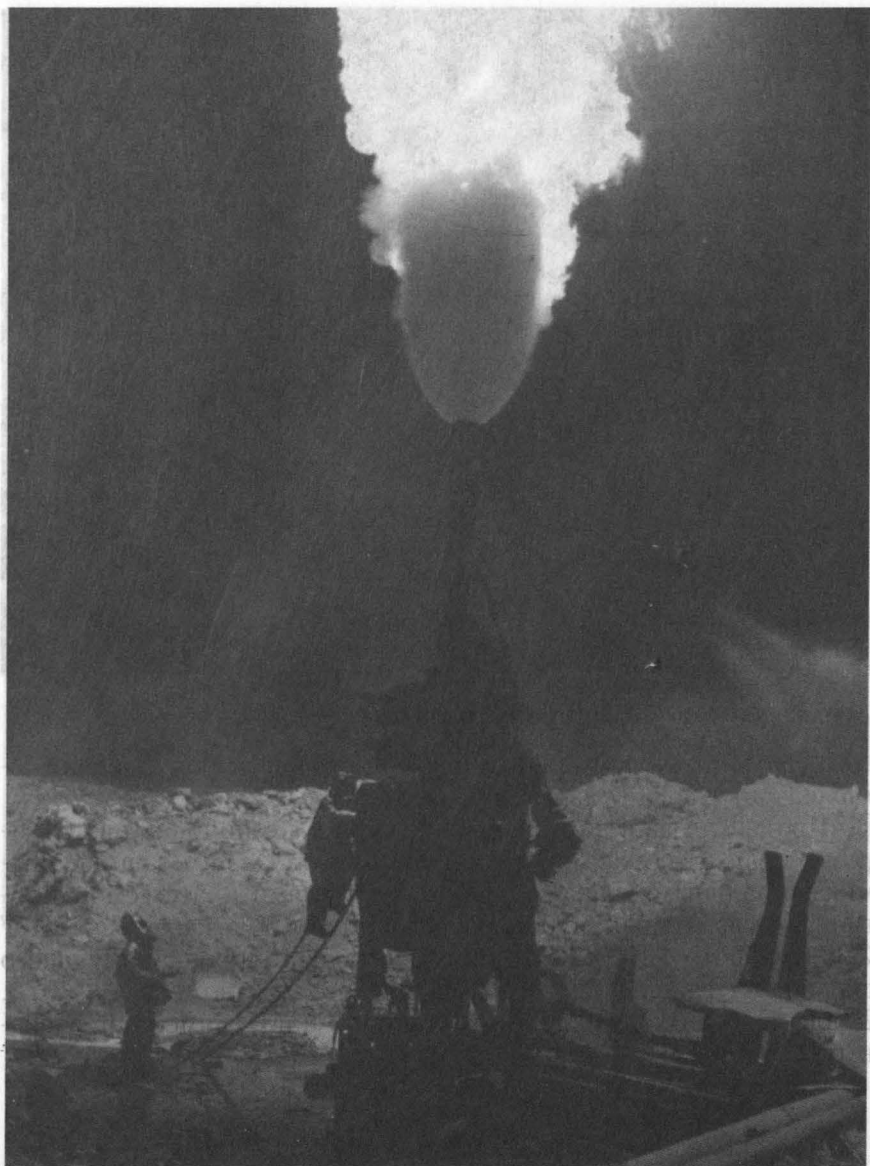
Фото 4.16. В 23 часа 30 минут, превенторная установка была надежно закреплена на устье скважины, самоотверженный труд нефтяников увенчался успехом
