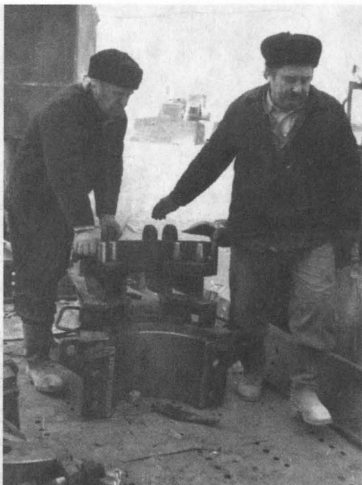
Фото 4.2. Подготовка полушарниров на технической площадке
