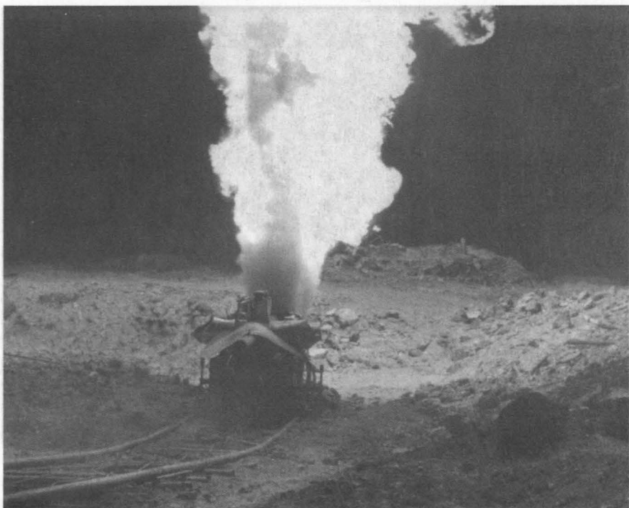
Фото 4.8. Первое подтаскивание компоновки по рельсам к устью скважины
