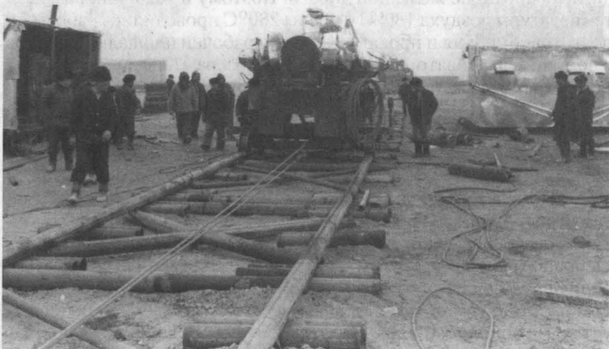
Фото 4.5. Опробование работоспособности узлов гидронатаскивателя (компоновки) на технической площадке
