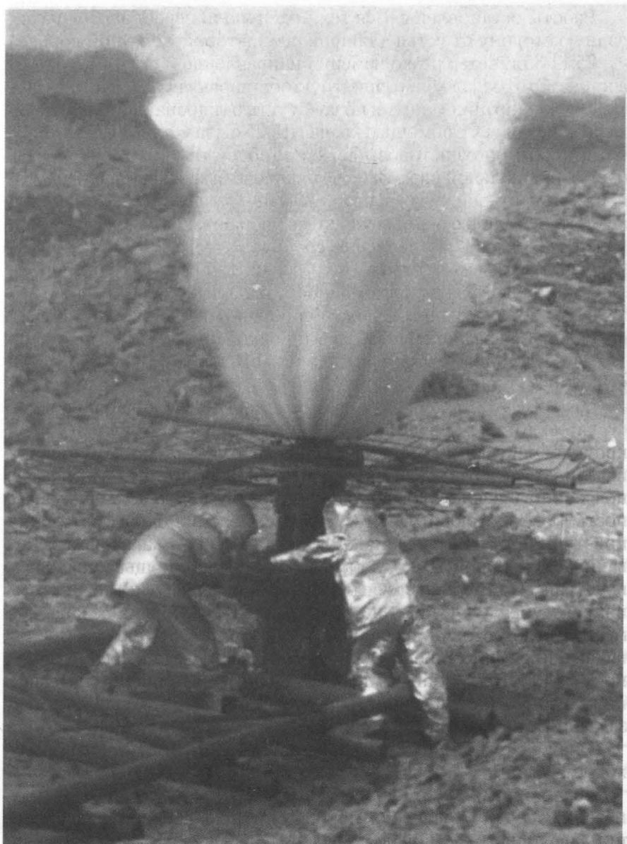
Фото 4.6. Монтаж полушарнира
