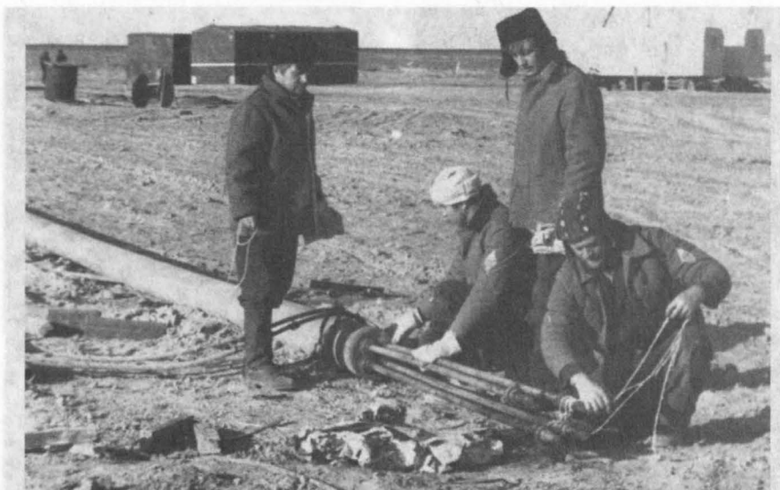
Фото 4.10. Защита маслопроводов управления превенторами и гидронатаскивателя компоновки
