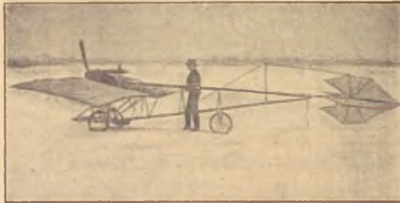
Рис. 49а. Аэропланъ Сантосъ-Дюмона „Demoiselle“ самый легкій изъ существующихъ аэроплановъ (вѣсиль лишь 7 пудовъ).
