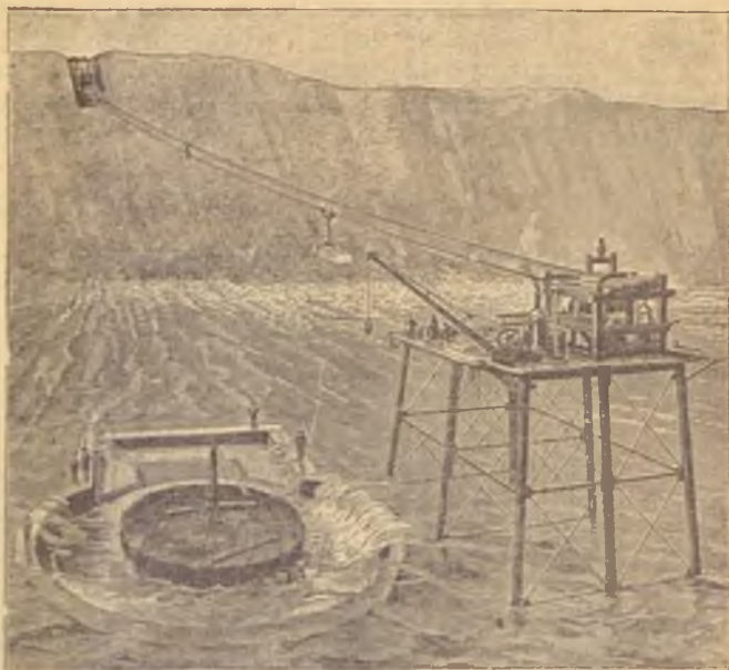
Рис. 22. Сооруженнѣ для постройкн маяка Beachu Head.
