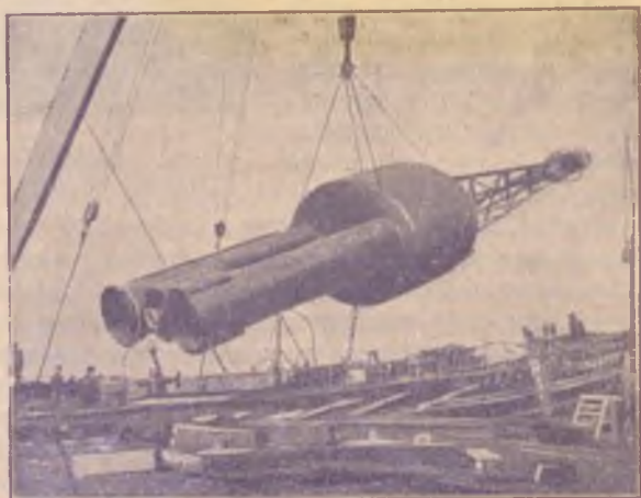
Рис. 88. Установка при помощи крана свѣтящаго и снабженнаго сиреной бую.
