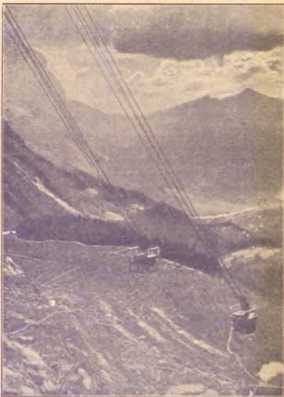
Рис. 76. Скрещеніе двухъ вагоновъ, идущихъ въ разныхъ направленіяхъ: одинъ—вверхъ, другой—внизъ
