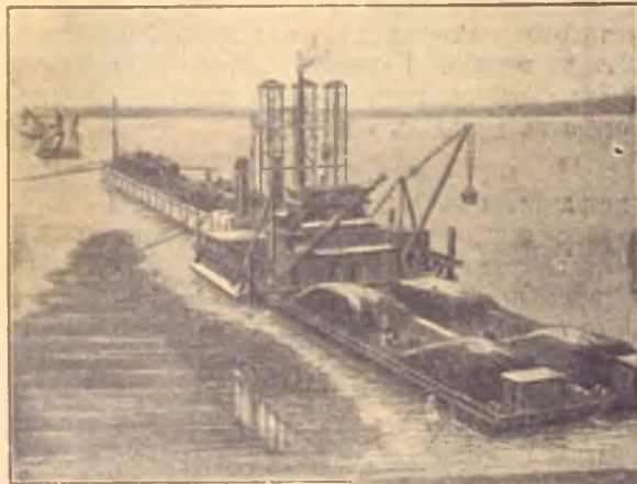
Рис. 64. Машина для бетонирования трубъ въ туннель Детройтъ.
