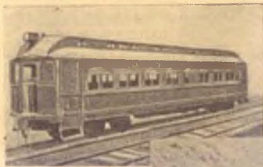
Рис. 73. Стальные пудмановскіе вагоны, сохранившіеся въ неповрежденномъ видѣ послѣ желѣзнодорожной катастрофы.
