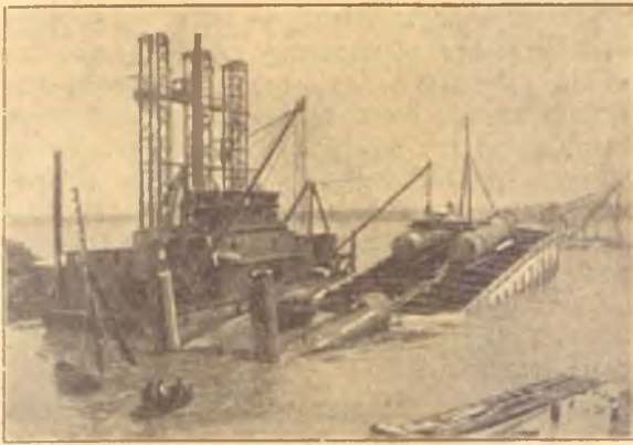
Рис. 63. Гигантскія металлическія трубы во время погруженія въ воду на р. Детройтъ.
