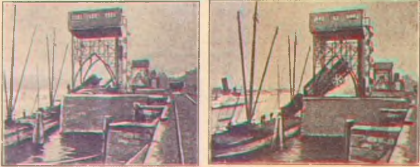
Рис. 74. Приспособленія для непосредственной перегрузки товаровъ пазъ железнодорожныхъ вагоновъ на суда.
