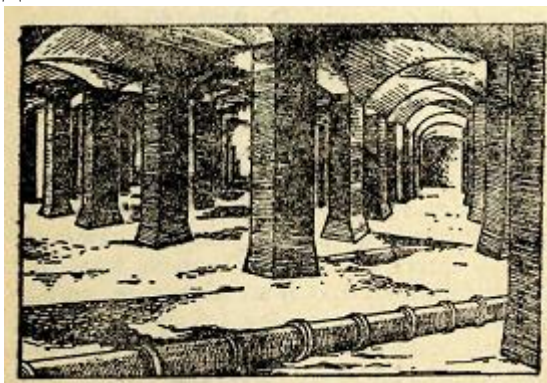
18-сүурет. Ішінен құмы алынған қалалық сүзгінің ішкі түрі.
