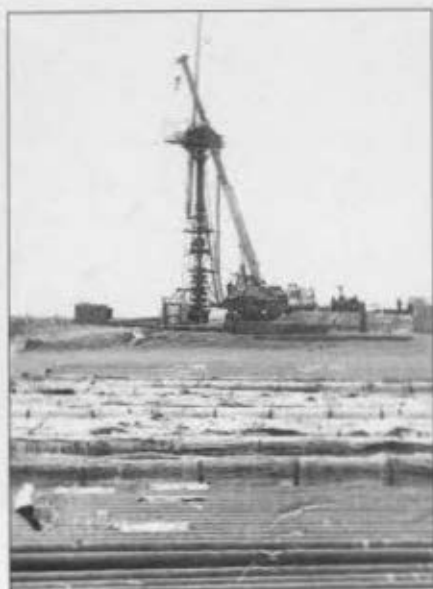
Атышулы №37 Теңіз ұңғымасындағы апатты ауыздықтауға арналған шетелдік қондырғы қызмет үстінде
