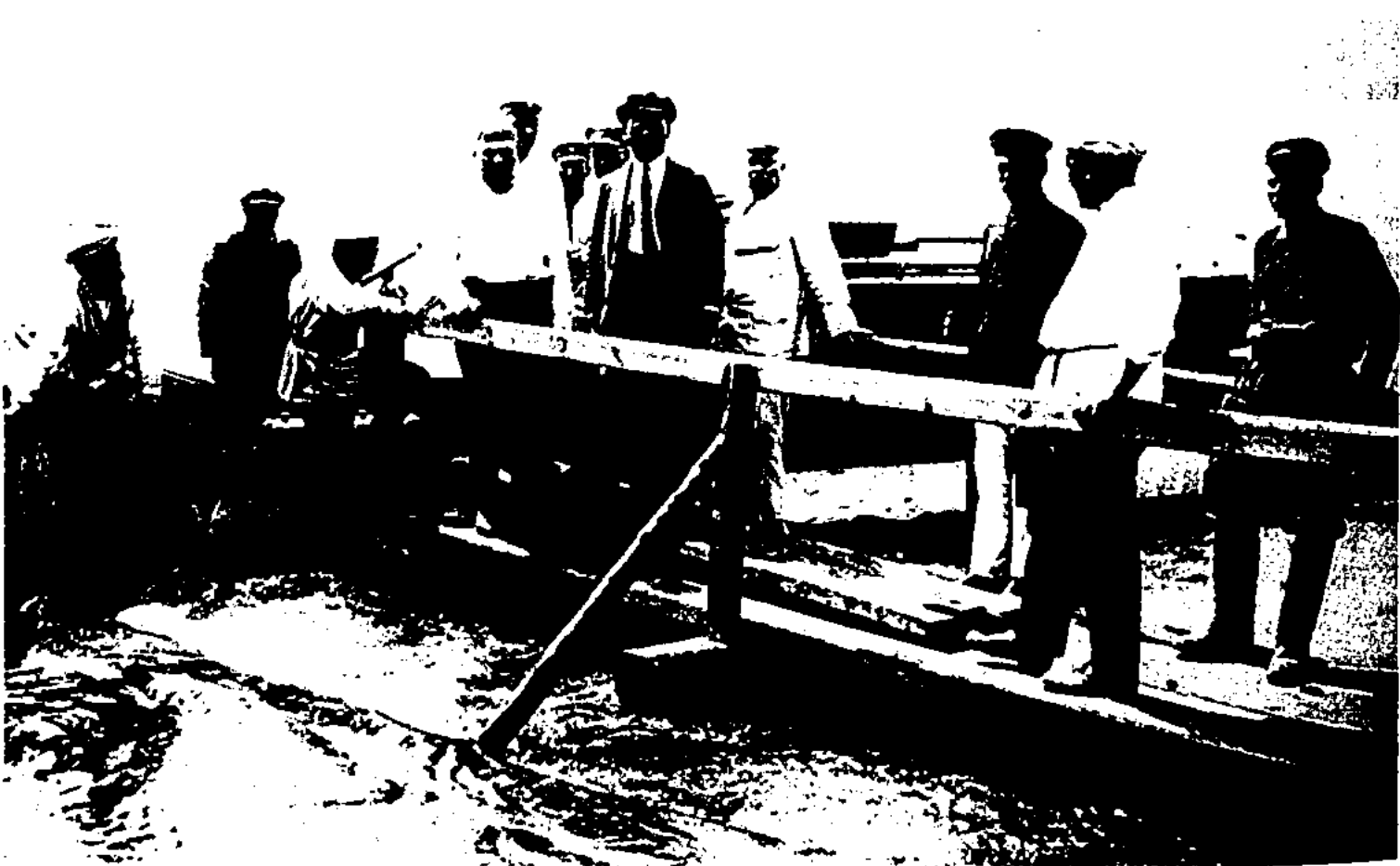
Т. Рыскулов на строительстве Турксиба
